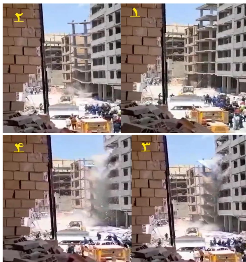
شکل ۳۵- روند تخریب سازه اولیه و برخورد آن با سازه قاب خمشی مجاور
