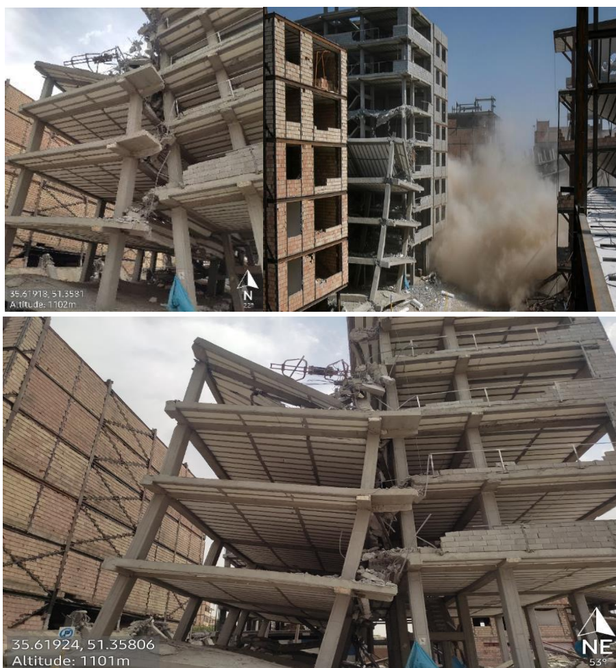
شکل ۳۴ - نمایی از رویداد اولیه (سقوط سازه بتن آرمه بر روی سازه مجاور)
