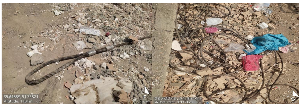
شکل ۴۸- نمونه سیم‌های بوکسل مورد استفاده در عملیات تخریب سازه‌های غیرقانونی محدوده
