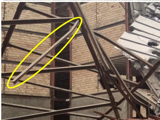
شکل ۴۱ - نمونه‌هایی از المان‌های ضعیف در برخی از سازه‌های فولادی محدوده (به نسبت ارتفاع و بارگذاری سازه)
