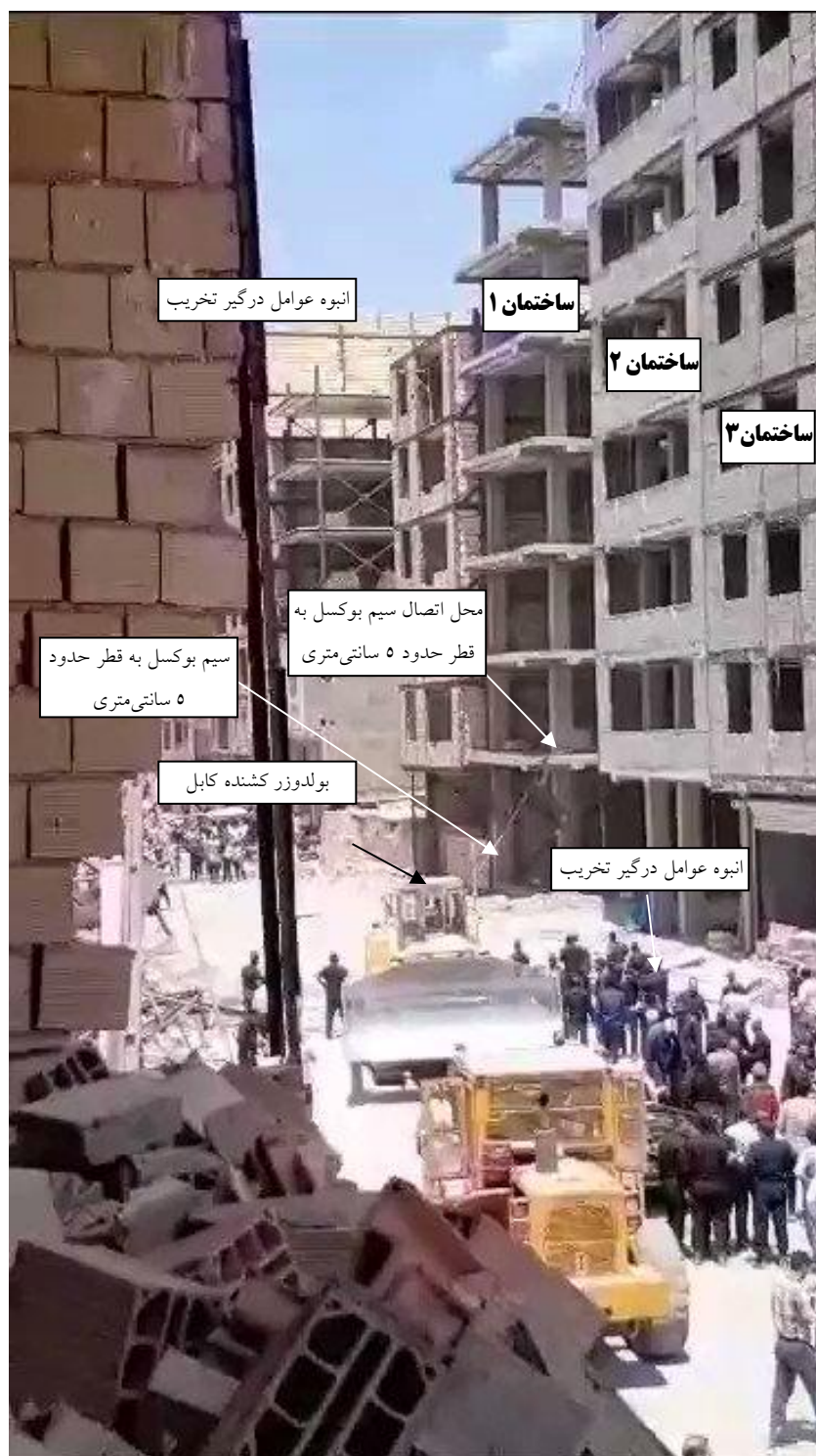
شکل ۲- عکس تخریب به روش کششی ساختمان ۱
