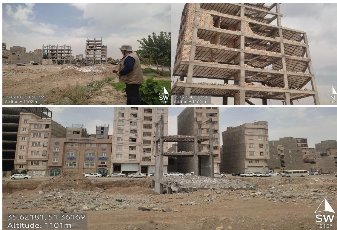
شکل ۴۶- نمایی از برخی سازه‌های دچار انحراف در بخش شرقی محدوده
