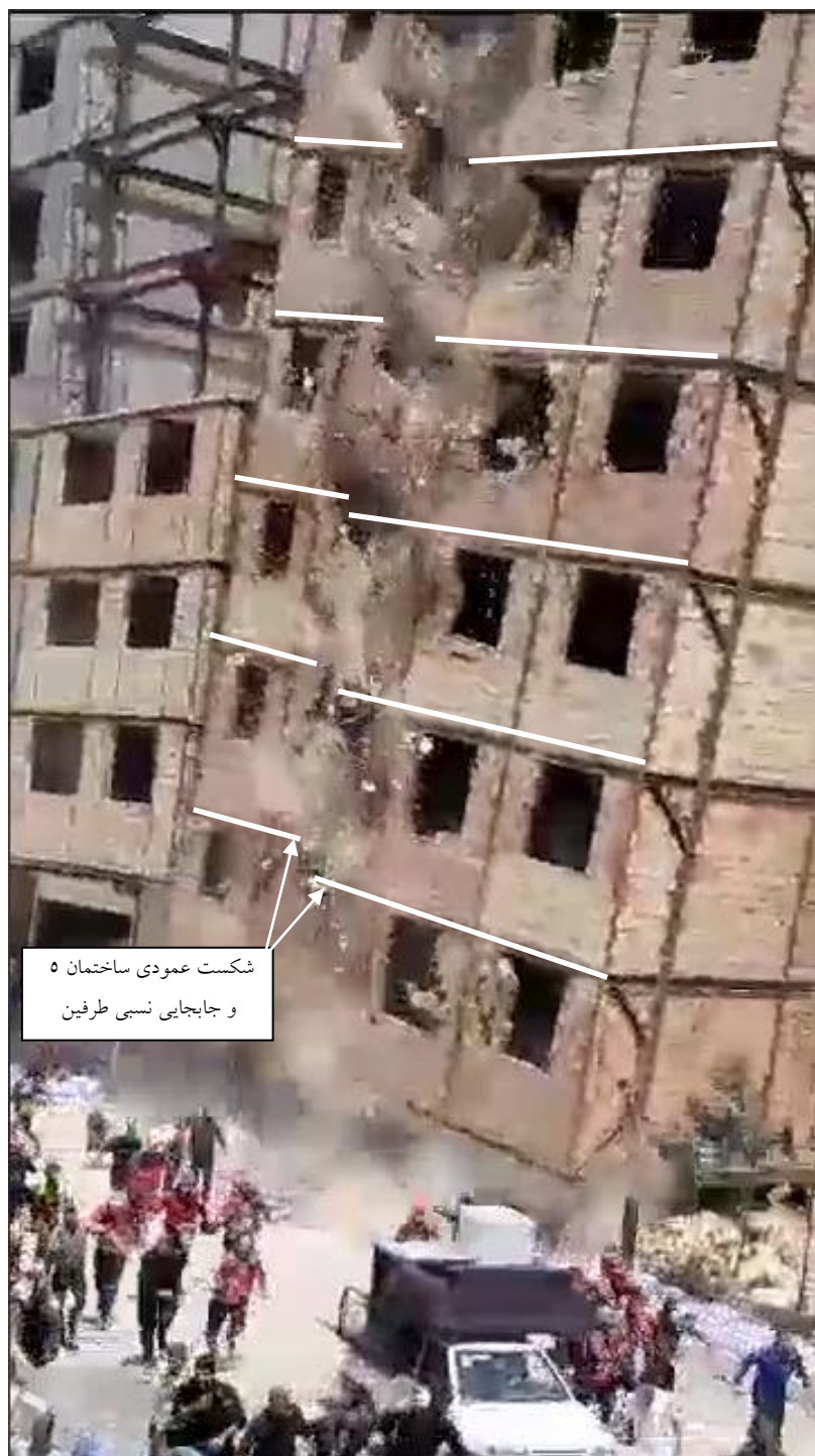
شکل ۷- شکست و دو تکه شدن و افتادگی بخش جنوبی ساختمان ۵ در اثر ضربه ساختمان ۴ و شکست ستون جنوب شرقی ساختمان ۵ (به نظر می‌رسد که این ساختمان پیش‌تر ضعیف شده بود)
