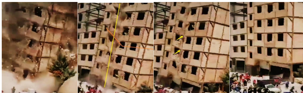
شکل ۳۷ - روند تخریب سازه اسکلت فلزی (پنجمین سازه در جنوب محل تخریب اولیه)
