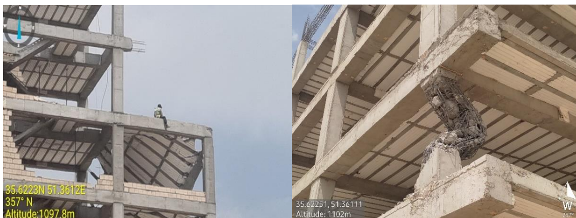
شکل ۴۹- نمونه‌هایی از اعضای تخریب شده با تکنیک کشش توسط سیم بوکسل (برای تخریب سازه)
