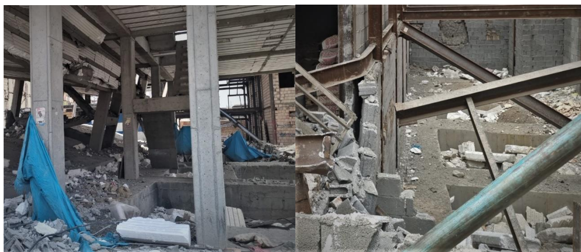
شکل ۴۸- نمونه‌هایی از فونداسیون‌های اجرا شده قابل مشاهده در سازه‌های محدوده
