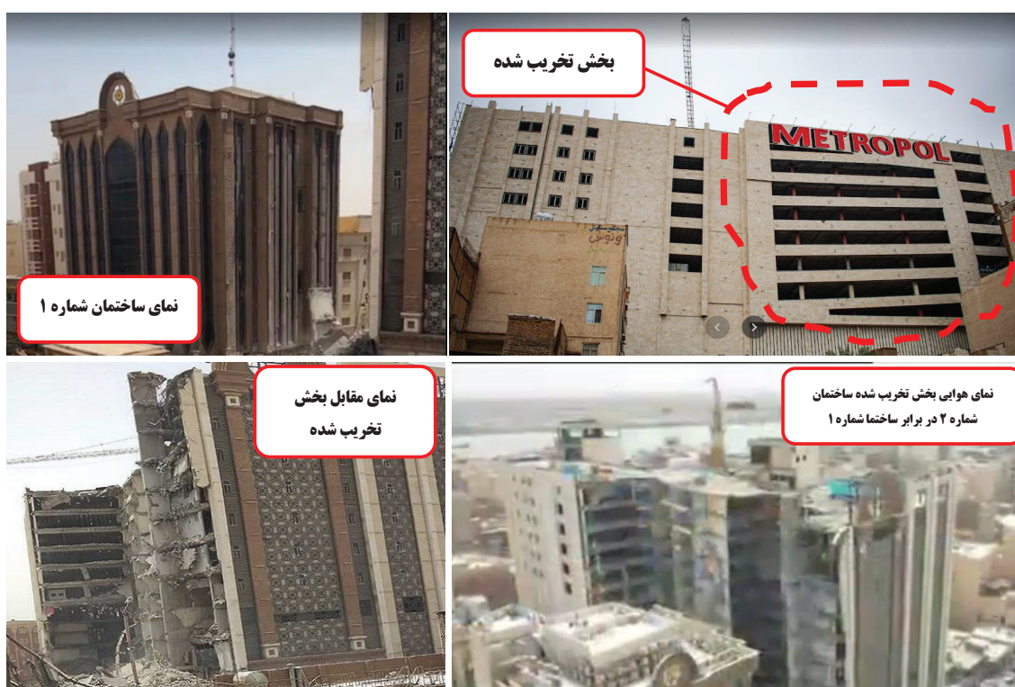
شکل (۳) نمای ریزش رخ داده در ساختمان
