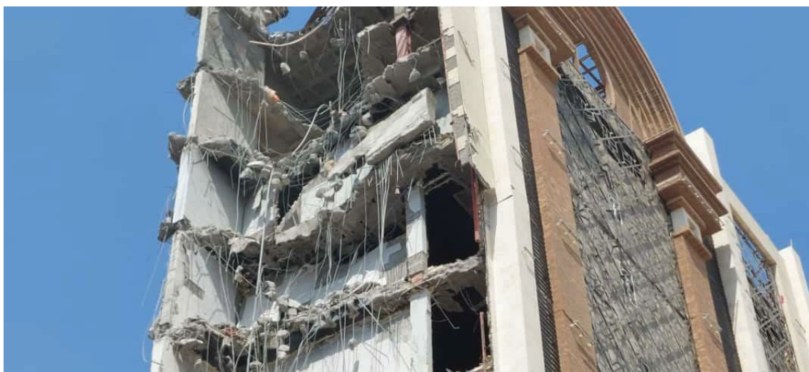
شکل ۱۸) بریده شدن دال‌ها در محل اتصال به ستون و دیوار برشی
