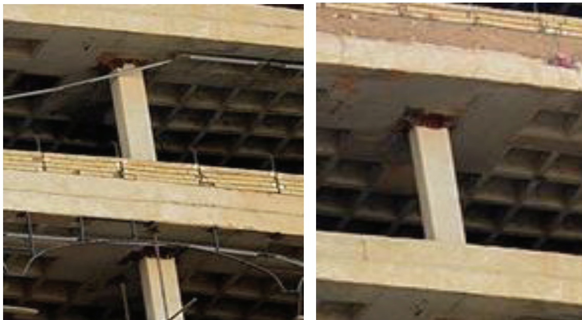
شکل ۱۹) وضعیت اتصال وافل اسلب‌ها به ستون‌های سازه
